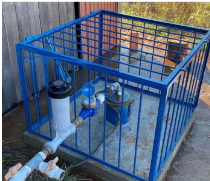
Figura 4. Modelo de proteção do poço.
