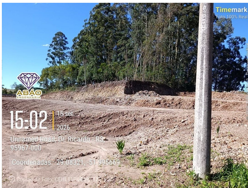
Foto 1. Vista do talude de corte junto ao maciço de eucaliptos, com exposição do perfil de solo e rocha alterada na área do loteamento.
