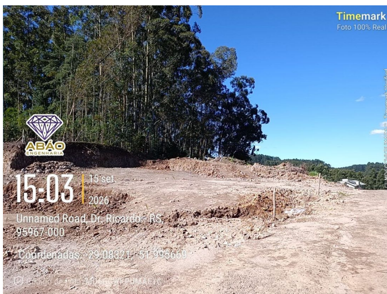
Foto 2. Área terraplenada do loteamento, com talude de corte e estacas de marcação topográfica.
