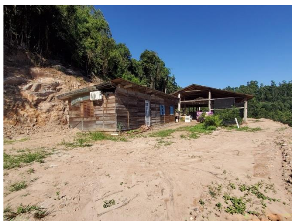
Figura 11- Moradia sobre aterro lançado e corte íngreme atrás, com rocha alterada em blocos, no setor RS_DOUTORR_SR_008_SGB.
