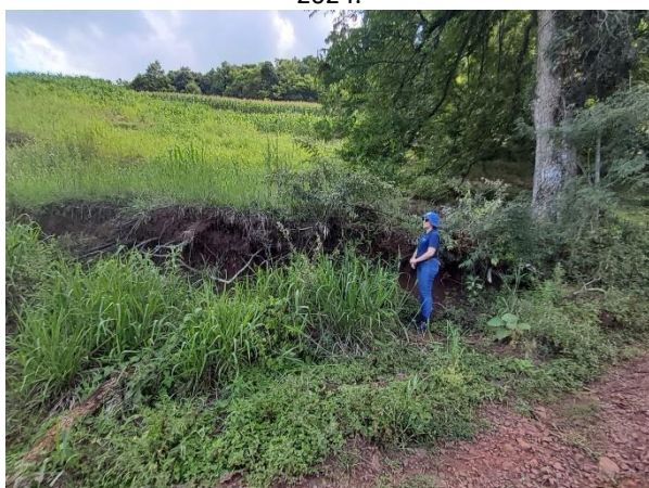
Figura 8- Vista da encosta com degraus de abatimento no setor RS_DOUTORR_SR_001_SGB.
