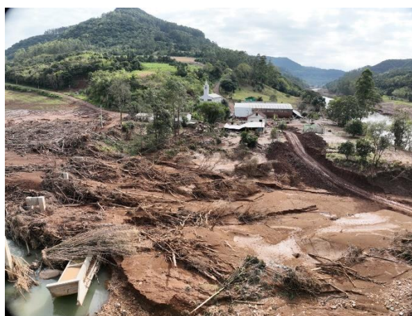
Figura 13- Imagem de drone após o evento de abril/maio de 2024 da destruição da ponte no arroio Zeferino e da Comunidade Barra do Zeferino. Setor RS_DOUTORR_SR_013_SGB.
