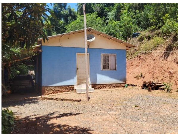
Figura 10- Corte íngreme próximo a moradia no setor RS_DOUTORR_SR_007_SGB.
