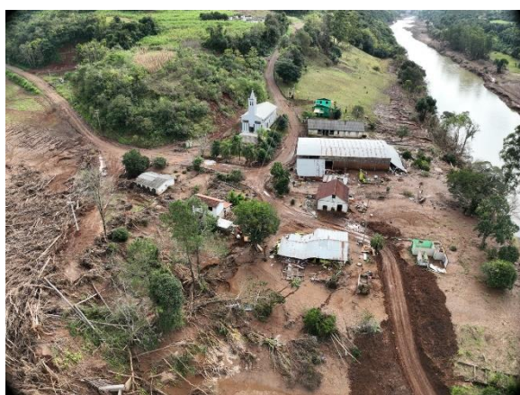
Figura 12- Imagem de drone após o evento de abril/maio de 2024 da destruição na Comunidade Barra do Zeferino. Setor RS_DOUTORR_SR_013_SGB.
